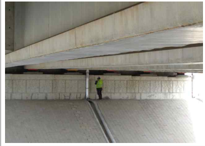
▲ 교량받침 도보 근접조사
