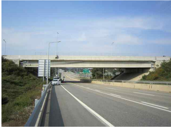
교량 측면 전경
