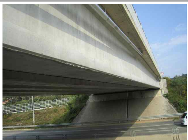
교량 거더 전경
