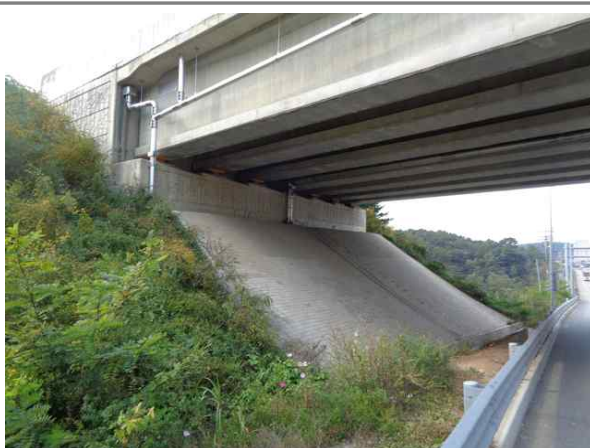
교량 하부 전경
