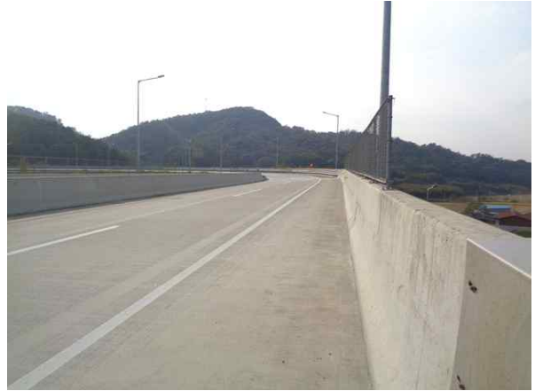
교량 상부 전경
