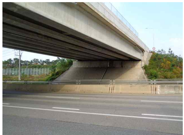
교량 하부 전경
